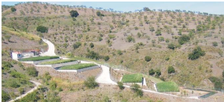
Kläranlage ALBONDON, Granada, Spanien
