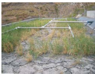
Schlammakkumulation nach 2 Jahren Betrieb
