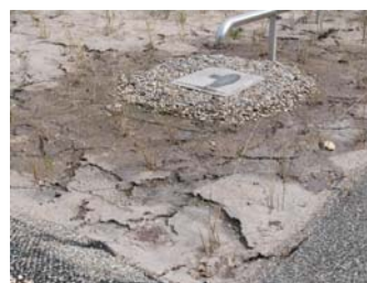
Schlammakkumulation nach 2 Jahren Betrieb
